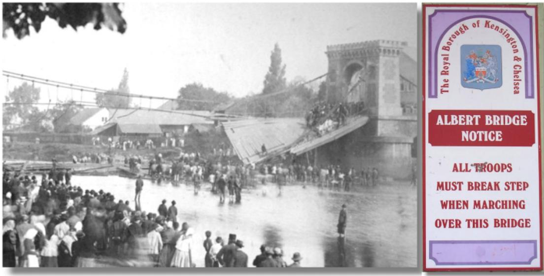
Abb. 5 Resonanzkatastrophe: Brückeneinsturz
