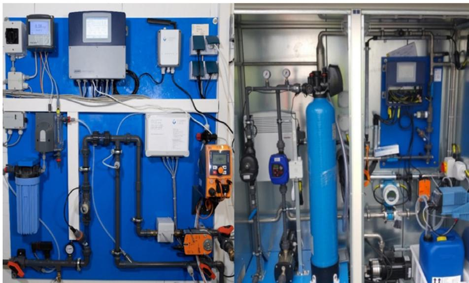
**Bild 10:** Wasserdatenmanagementsystem WDM inklusive bedarfsgerechter Bioziddosierung und weiteren Messperipherien (z. B. pH-Wert, Leitfähigkeit, Zusatzwasser, Abwasser) als Indoor-Lösung (links) und in einem wetterfesten Schrank mit Sandfilter (rechts)
