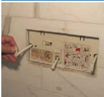
Ziehen Sie die Haltestangen aus dem Spülkasten heraus und legen Sie diese ab.
