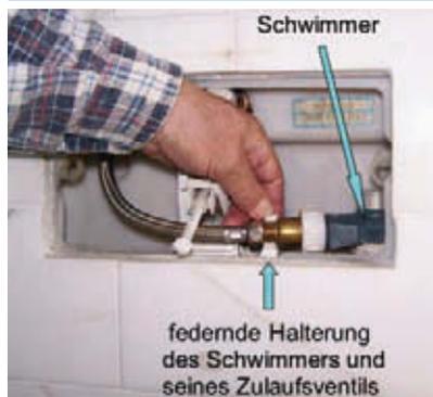
Drücken Sie den Schlauch der Wasserzuleitung zum Schwimmer aus seiner Klemmverbindung heraus. Damit ist der Schwimmer von jeglicher Verbindung zum Spülkasten befreit.
