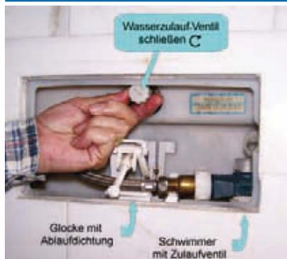
Schließen Sie nun das Wasserzulauf-Ventil (den Zulaufhahn) für den Spülkasten und betätigen Sie danach die Spülung (ziehen Sie an der Glocke), um den Spülkasten zu entleeren. Sehen Sie sich jetzt in aller Ruhe an, wie die einzelnen Bauteile Ihres Spülkastens angeordnet sind und vergleichen Sie alles mit den zeichnerischen Darstellungen in Abb. 18 bis 22.
