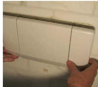
Drücken Sie den Spülkasten-Deckel von unten in Richtung nach oben so weit an, dass er federnd aus seiner oberen Halterung herausklickt, und oben leicht nach vorne herausschwenkt.
