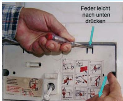
Um die Abdeckung des Spülkastens zu entfernen, müssen Sie die oberen zwei (links und rechts angebrachten) Kunststoff-Federn etwas eindrücken und dabei den Deckel leicht zu sich (nach außen) ziehen. Nachdem der Deckel oben ausgeklickt ist, kann er leicht abgenommen werden.
