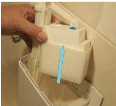
Der Schwimmer, der samt seines Gehäuses nur von der nun losgedrehten Verschraubung im Spülkasten gehalten wurde, kann jetzt aus dem Spülkasten vorsichtig herausgenommen werden.
