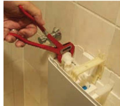
ten mit der Hand losdrehen. Mit der Wasserpumpenzange geht es ganz leicht, aber Sie müssen sich vorher die Ringmutter gut anschauen, denn oft ist es gar nicht auf den ersten Blick ersichtlich, in welcher Richtung sie losgedreht werden sollte: Wohl aber auf den zweiten Blick – siehe hierzu Abb. 24b.
