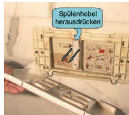
Nehmen Sie den Spülkasten-Deckel ab und entfernen Sie danach durch einen
