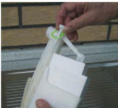
Um das Schwimmer-Gehäuse innen reinigen zu können, wird der Schwimmer mit Hilfe der Wasserstand-Einstellschraube so weit herausgeschraubt, dass er sich ausschwenken lässt.
