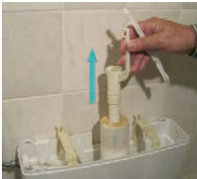
Die Glocke will sich aber manchmal nicht herausziehen lassen und scheint irgendwo fest zu sitzen. Sie ist oft unten eingeklickt. Eine ähnliche leichte Drehung nach links (wie beim Öffnen einer Ketchup-Flasche) genügt, um die Glocke mit allem „drum und dran“ leicht herausnehmen zu können. Das ist sehr einfach.
