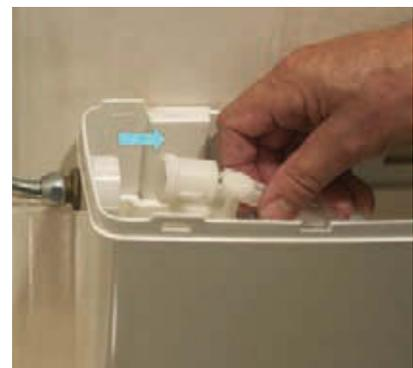
Nachdem Sie die Ringmutter mit der Zange gelockert haben, lässt sie sich mit der Hand losschrauben und von der Verschraubung des Zulaufrohrs abziehen.
