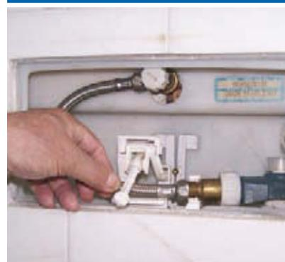
Da es bei den Wandeinbau-Spülkästen gewisse Unterschiede in der Anordnung der einzelnen Bauteile gibt, können Sie sich am schnellsten eine Übersicht über die Frage „who is who“ auf die Weise verschaffen, dass Sie den flexiblen Schlauch des Wasseranschlusses ausfindig machen. Er führt vom Wasserzulauf zum Schwimmerventil – also zum Schwimmer, der oft in einem kleinen Kunststoff-Gehäuse verborgen ist und eine selbstständige Einheit bildet.
