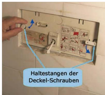
Drehen Sie beide Haltestangen der Deckelschrauben vorsichtig um 90° gegen den Uhrzeigersinn, bis sie spürbar aus ihrer Halterung herausgeklickt sind.
