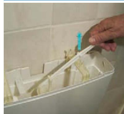
Wenn Sie es sich zutrauen, nehmen Sie nun Schritt für Schritt einzelne kompakte Bauteile des Spülkasten-Innenlebens vorsichtig heraus. Sie sind im Spülkasten
