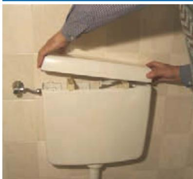
Öffnen (entfernen) Sie den Spülkasten-Deckel und schließen Sie die Wasserzuleitung am Spülkastenventil ab. Dieses Ventil befindet sich oft außerhalb des Spülkastens – wie auf unserem Foto – manchmal jedoch auch innen im Spülkasten (am Eingang der Wasser-Zuleitung, die aus einem Wasserleitungsrohr aus der Wand kommt)
