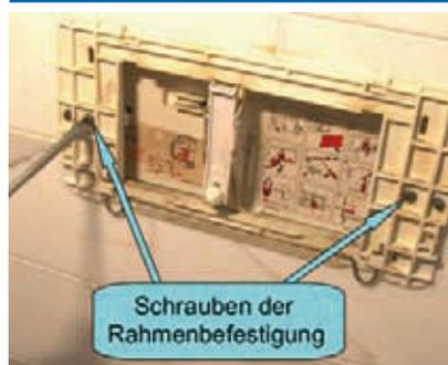
Schrauben Sie den Spülkasten-Rahmen mit den links und rechts angebrachten (und im Foto angezeigten) Schrauben ab.
