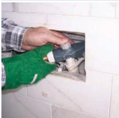
Drehen Sie die Kunststoff-Überwurfmutter der Wasserzuleitung zum Schwimmer auf. Das geht am besten mit Hilfe eines „rutschfesten“ Handschuhs. Den Schlauch dieser Wasserleitung können Sie vorübergehend in den Leerraum links herabhängen lassen.
