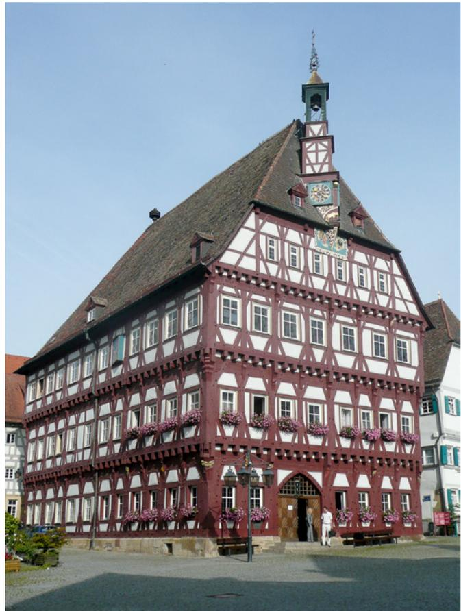
**Abb. 1.6:** Das Rathaus von 1440 in Markgröningen, Baden-Württemberg (© 2009) steht auf 54 Eichensäulen: auf 19 »schwachen« und 35 »starken«, die im Querschnitt 60 / 60 cm messen. Drei Stockwerke sind aus Eichenholz gebaut. Darüber befinden sich drei Dachgeschosse aus Nadelholz. Als 1400 mit dem Bau begonnen wurde, zählte die Ortschaft etwa 1200 Einwohner. Aus dem verbauten Holz könnte man heute 47 Einfamilienhäuser bauen.
