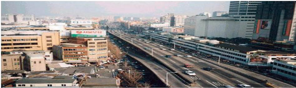
**Figura iii.** Autopista arteria urbana, que luego recibió una segunda vía de alta velocidad elevada de seis pistas. Fuente: [goo.gl/RqLWMScontent\\_copy](https://goo.gl/RqLWMScontent_copy)
