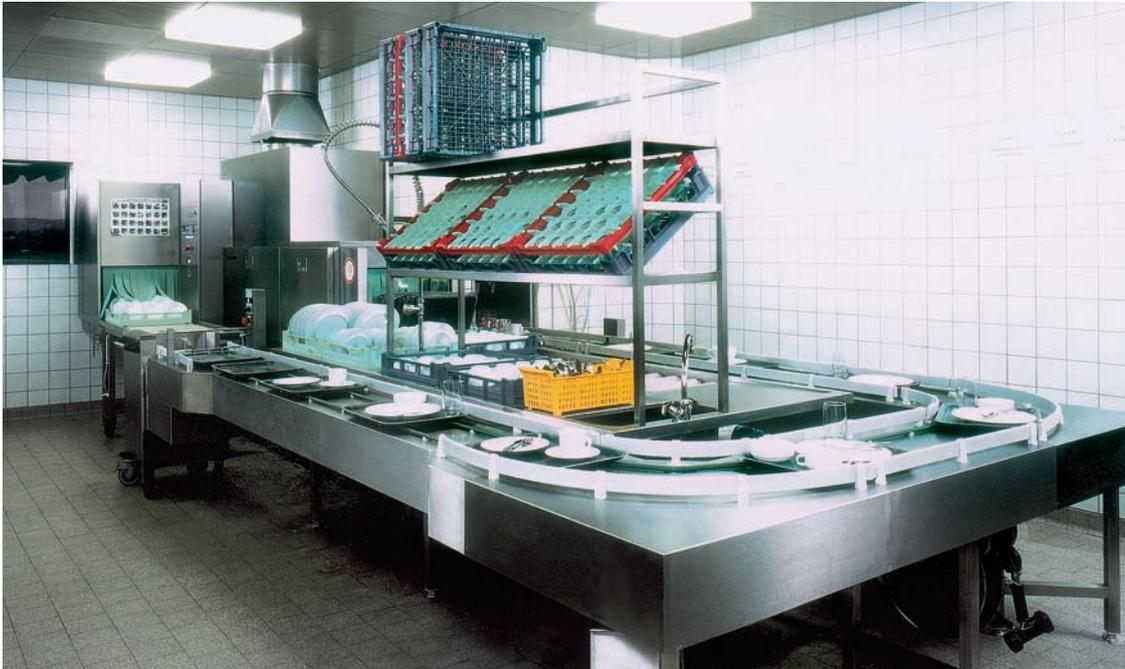
**Bild 2.7** Automatische Geschirrspülanlage mit vorgelagerter rationeller Absortiertechnik für den Bankettbereich eines Hotels
