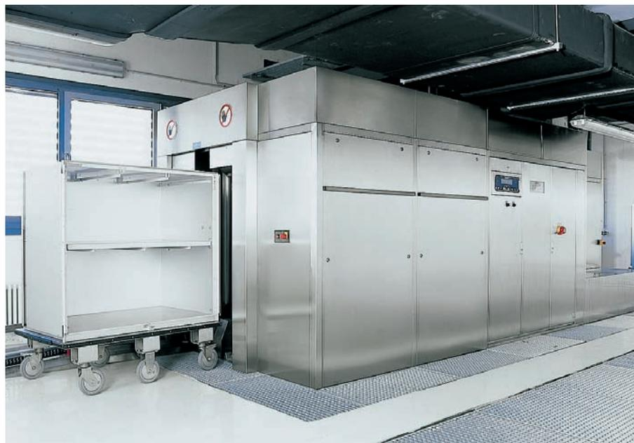
**Bild 2.9** Wagenwaschanlage in einer Zentralküche der Patientenverpflegung
