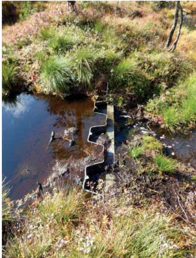
Abb. 1.6. Metallwehr zum Verschliessen eines Abflussgrabens in einem Hochmoor (Foto: Angéline Bedolla).
