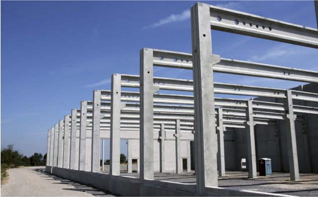
**Bild 9.9** Spannbetonkonstruktion einer Halle
