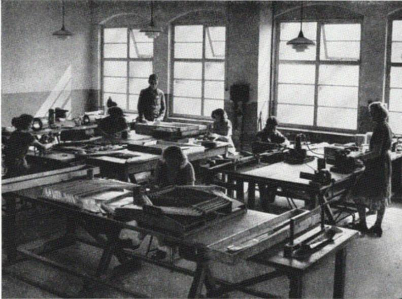
Abb. 15. Spulen-Wickelei. Herstellung von Formspulen für eine größere Leistungseinheit (Werkbild: H. Schümann, Lübeck)
