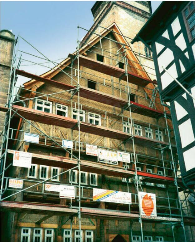
Abb. 22 Sanierung und Umbau des Hauses Markt 2 in Alsfeld von 1350, Neuausfachung mit Strohlehm (Ausführung Fa. Talis 1989)
