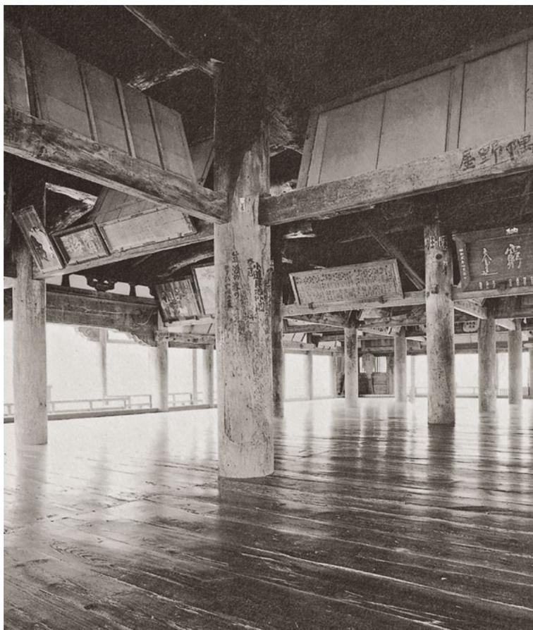
8 Im Senyo-kaku in Miyajima/Hiroshima (J) wird das Dach von rasterartig verteilten Stützen getragen.
