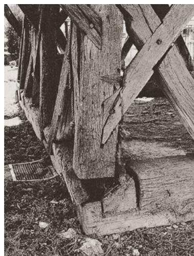
16 Der Schub des Eckständers dieses Glockenturms in Malé Ozorovce (SK) unterstützt die Drehbewegung des drehwüchsiges Schwellholzes. Da es wegen des Hakenblattes nicht ausweichen kann, muß es reißen.
