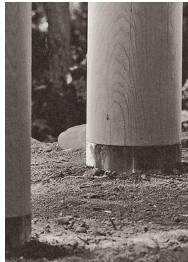
30 Die Pfosten des Isejingu werden durch Kupferblech gegen die Feuchtigkeit des Erdreichs etwas abgeschirmt.
