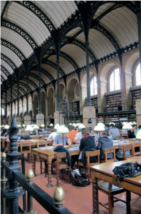
Die Bibliothèque Ste. Geneviève in Paris, entworfen von Henri Labrouste, zeigt die neue Leichtigkeit der Konstruktion, die durch die Einführung von industriell hergestelltem Gusseisen ermöglicht wurde. Labroustes Werk begründete eine neue Typologie, die heute als „konstruktiver Rationalismus“ bezeichnet wird. Hier wurde das Konzept der massenfertigten und nachfolgend zusammengefügt Architektur erstmalig angewandt.
