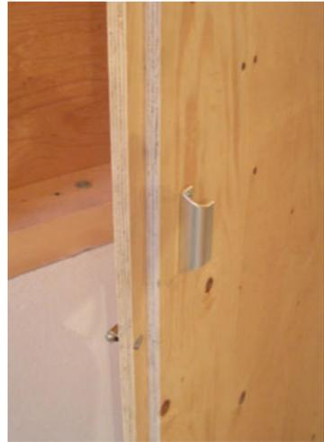
Zwei versetzt zueinander verschraubte Sperrholzplatten erzeugen die gefalzten rahmenlosen Türblätter die in die 4 cm dicke, ebenfalls aus 2 zusammengeschaubten Sperrholzplatten bestehende Wand schlagen
