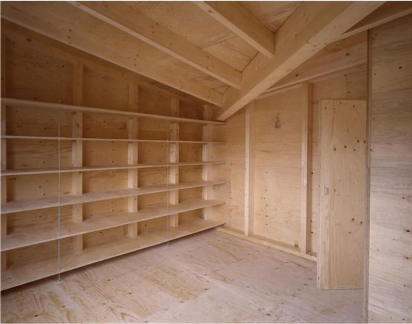
Die innen sichtbare Konstruktion wird zum Befestigen von Regalen verwendet
