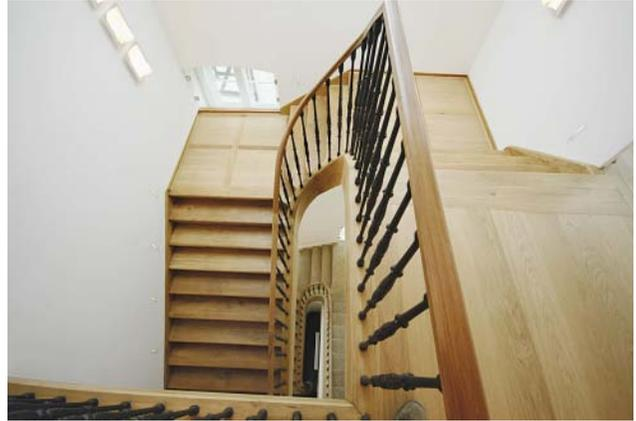
**Abb. 2.4:** Der Blick von oben auf die beiden neuen Podeste und das Treppenauge.
