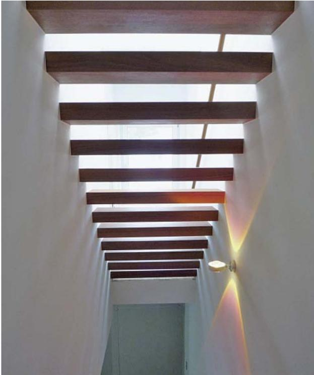
**Abb. 1.19:** Zwischen 2 Wände gespannte Trittstufen
