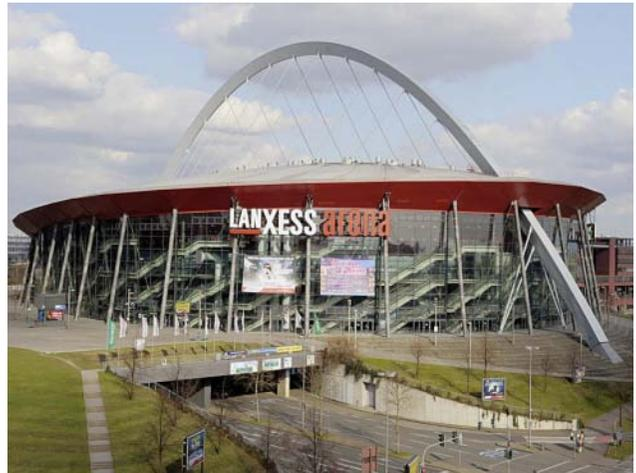
Abb. 1.18: Die Lanxess Arena in Köln, erbaut 1998, war Vorreiter für die ersten Sichtbetontreppen (Quelle: LANXESS arena).
