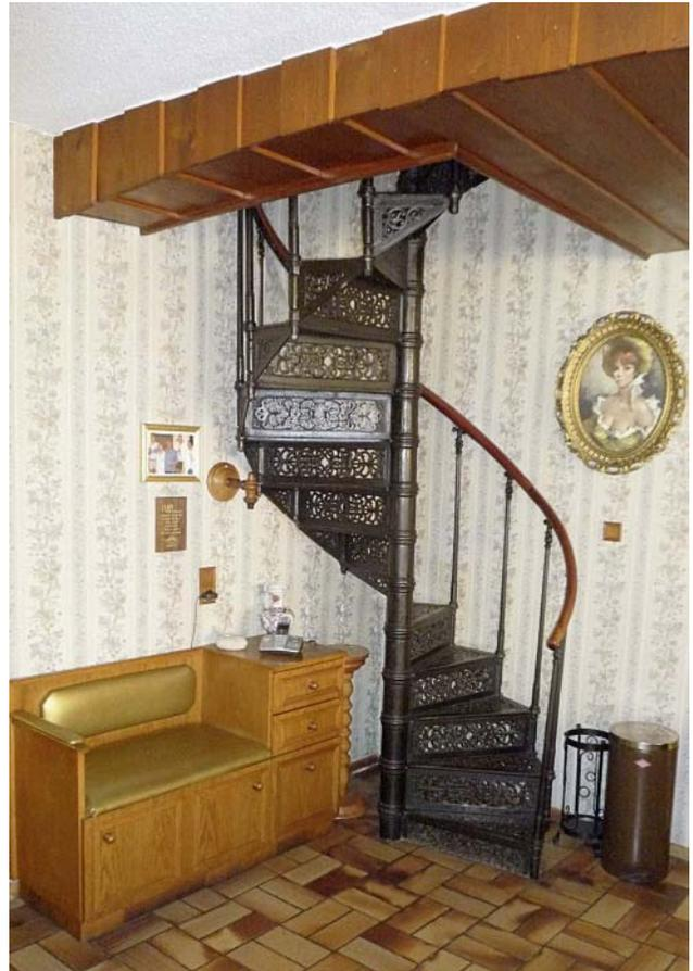
Abb. 1.9: Industriell gefertigte Spindeltreppe in Kraiburg, erbaut in der zweiten Hälfte des 19. Jahrhunderts
