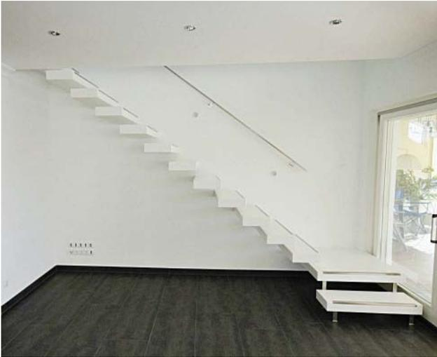
Abb. 1.16: Kragstufen mit weiß lackierter Oberfläche
