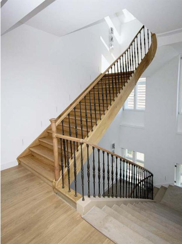
**Abb. 2.3:** Ansicht der Holztreppeanlage: Der Holzhandlauf der unteren Steintreppe wurde geschliffen und oberflächenbehandelt.
