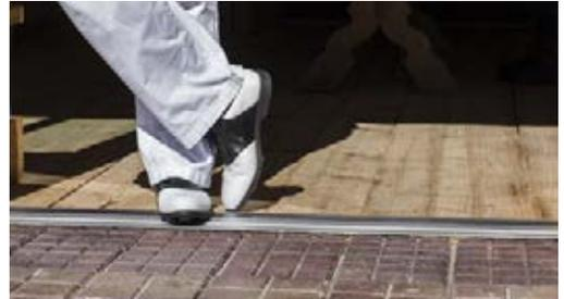
*Ein schwellenfreier Terrassenausgang dank Magnetdoppeldichtung.*
