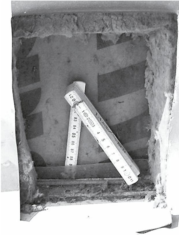
Bild 5: Dampfbremse?? Nicht ausreichend verklebte Naht!
