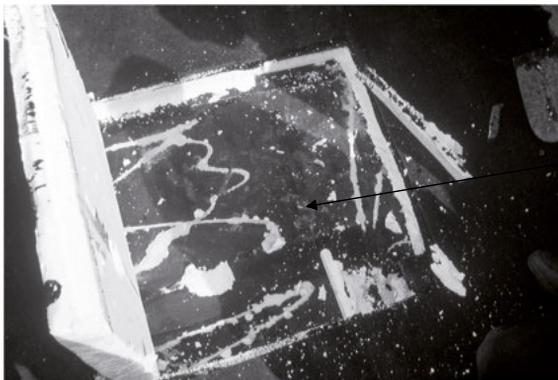
Unzureichender, unplanmäßiger Kleberauftrag. Der PUR-Kleber hat keinen Kontakt zur PS-Platte. Keine Lagesicherung.
