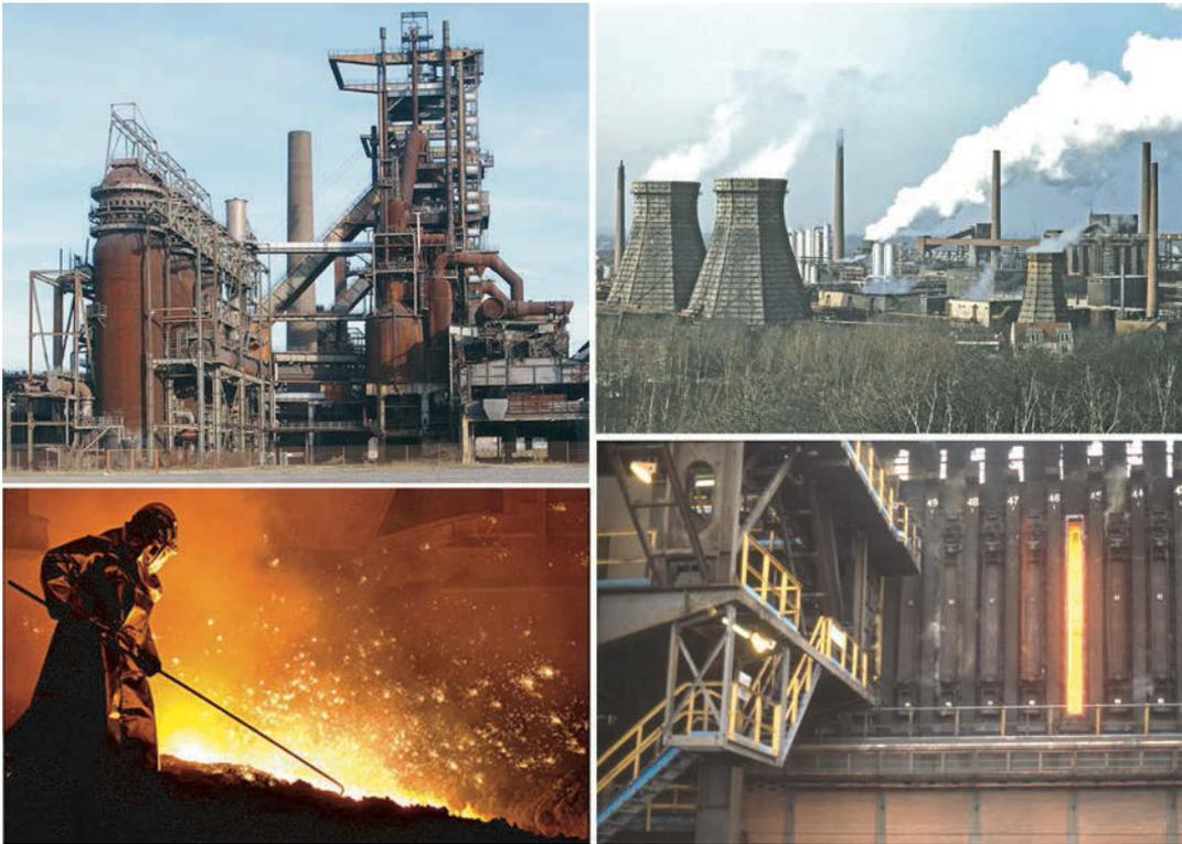
**Abb. 28:** Hochofenanlage und Abstich (links) sowie Kühltürme einer Kokerei und Kokereikammern (rechts) (Fotos: Internet).
