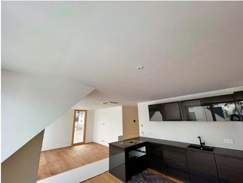
**Abb. 1.1:** Hohe Ansprüche erfordern eine hohe Qualität in der Ausführung; hier: Decke und Wände in der Qualitätsstufe GPQ4 mit Vliestapete und Anstrich.
