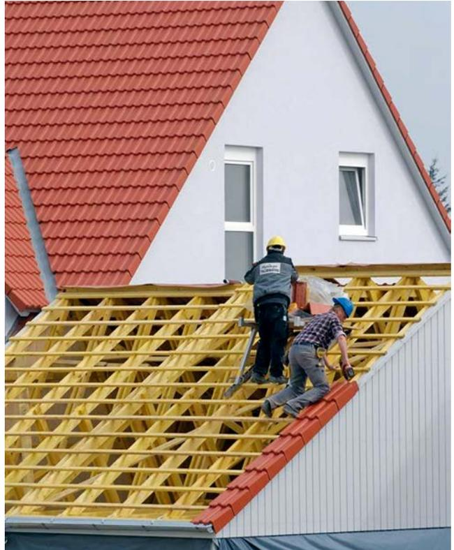
Abb. 2.1: Eindeckung einer Garage mit Dachsteinen
