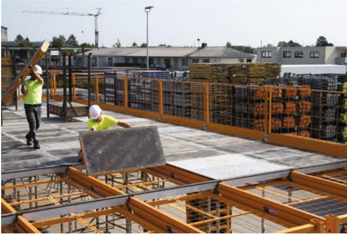
**Bild 1.25** Modul-Deckenschalung mit Seitenschutz und Fallschutzgitter, Bildquelle: ULMA
