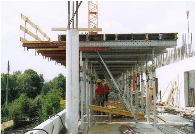
**Bild 1.23** Deckenrandtisch mit Seitenschutzgeländer, gesichert durch Zug- und Druckstützen, Bildquelle: NOE
