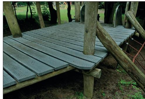
**Abb. 1.9:** Kunststoff-„Bretter“, die mit dem Abrieb und der Alterung Mikroplastik und Weichmacher in die Umwelt abgeben, sind ungünstige Entwicklungen. Sie sollten vermieden werden.
