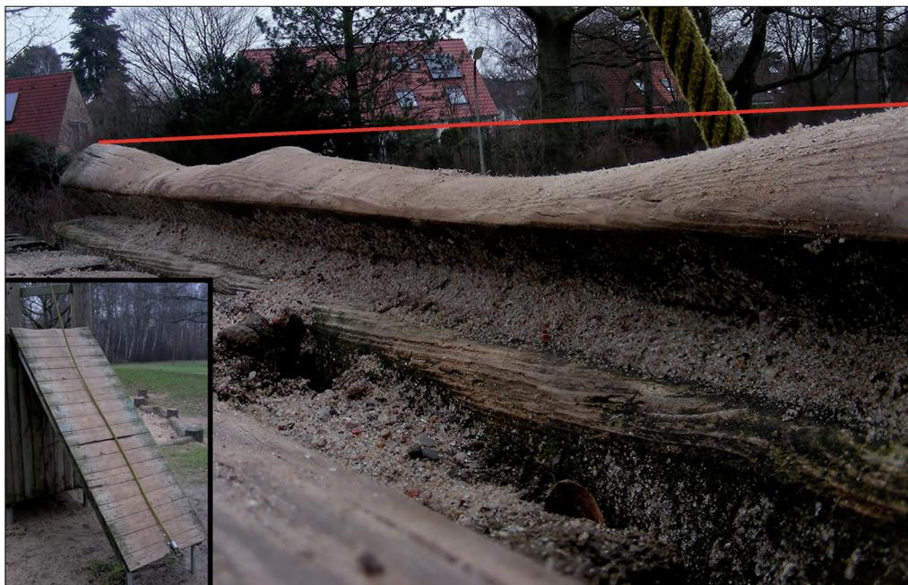
**Abb. 1.1:** Eckbild: Übersicht – Rampe mit Kletterseil: Das Spielplatzgerät wurde intensiv bespielt, das Holz der oberen Kante weist einen deutlich sichtbaren Verschleiß auf – das Material unterhalb der roten Linie wurde von Kinderfüßen abgetragen.
