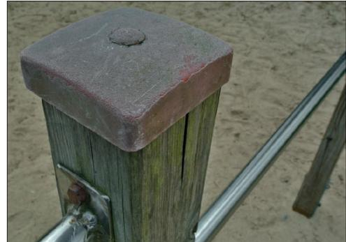
**Abb. 1.7:** Kunststoffabdeckung nach einigen Jahren: durch Benutzung, Wetter und UV-Licht abgerieben; eine stoffliche Wiederverwertung ist kaum möglich; Abdeckungen sind auch aus Holz oder Metall möglich (s. Abb. 4.48 und 4.54).
