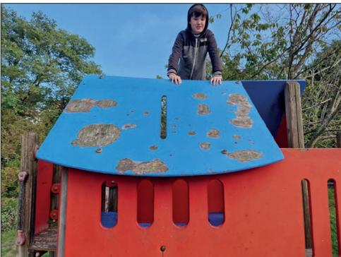
**Abb. 1.8:** Kunststoffbeschichtungen werden mit der Zeit zerstört; eine Wiederverwertung ist kaum möglich; naturbelassende Hölzer sind besser.
