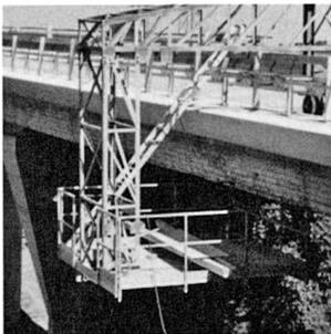
Das obere Bild zeigt einen Montagewagen beim Bau einer Autobahnbrücke. Der Montagewagen kann in einzelne Baugruppen zerlegt und örtlichen Gegebenheiten angepasst werden. Der kleine Bildausschnitt links lässt eine Montagestellung mit innenliegender Arbeitsbühne erkennen. Der Montagewagen ruht auf 4 Rädern, die eine Verschiebung in Brückenlängsrichtung gestatten. Das Fahrwerk ist samt Aufbau lenk- und feststellbar. Statisches Gleichgewicht wird durch Gegenballast gehalten.
