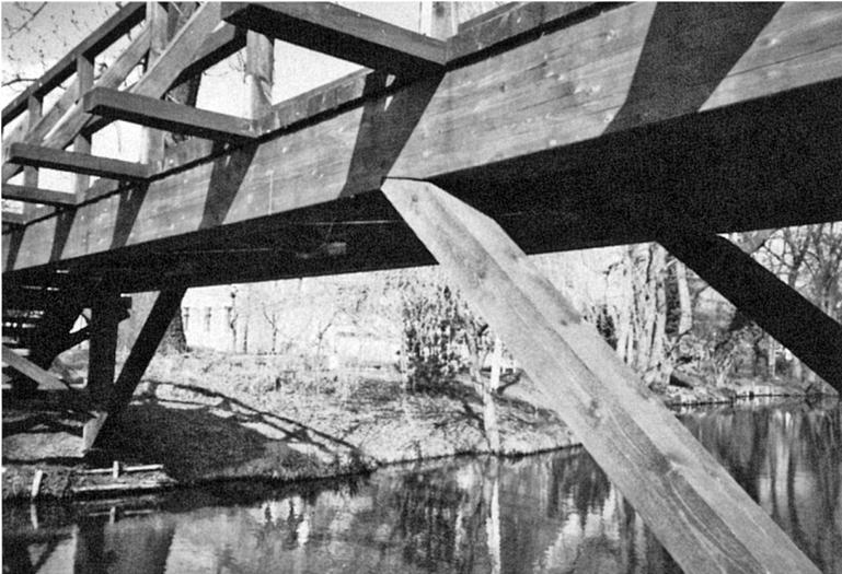
Der Brückenlängsträger belastet den Knoten, an dem die Strebe eingebunden ist, mit einer Vertikalkraft von  $F_V = 75 \text{ kN}$ .
