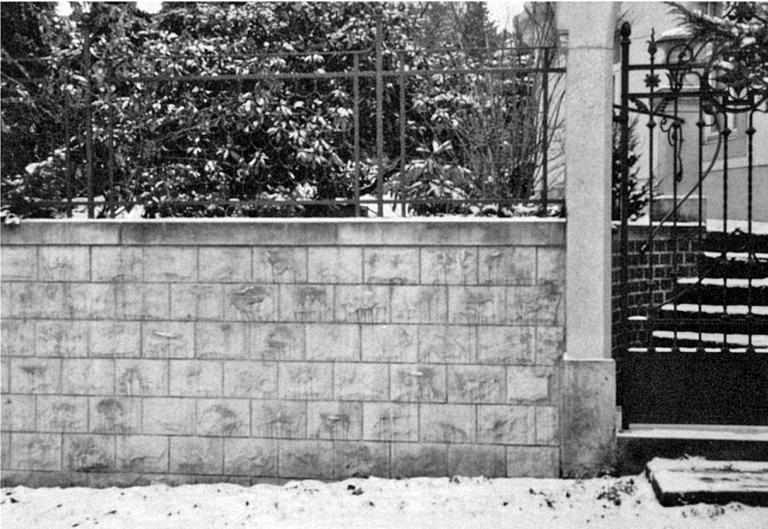
Ein 3 Meter langes Stück der abgebildeten Stützmauer hat ein Eigengewicht von 115 kN. Die einwirkenden Erdkräfte betragen 9 kN für die Stelle 1 und 45 kN für die Stelle 2. Gesucht sind die Resultierende  $F_R$ , ihr Winkel  $\alpha_R$  sowie der Durchstoßpunkt A an der Mauersohle.
