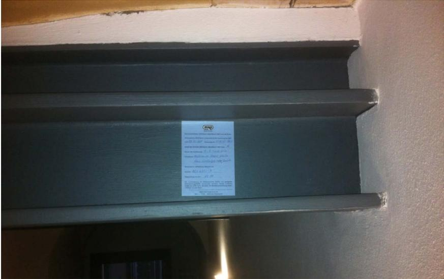
**Abbildung 3:** Reaktives Brandschutzsystem auf einem Stahlträger
