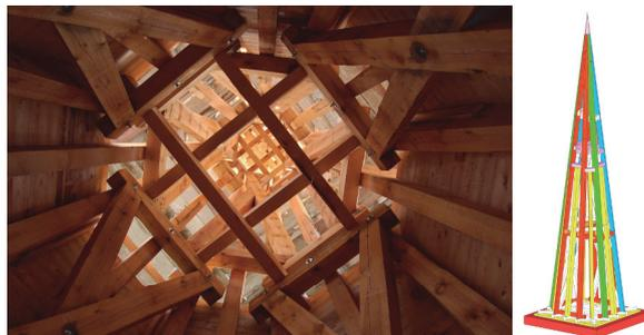
**Bild K.1 — Bauen in Vollholz – Wiedererrichtung eines Kirchturmes in Vollholz (Kiefer, Kernholz)**
