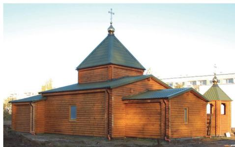
**Bild K.2 — Bauen in Rundholz – Blockbauweise – Neubau einer Russisch-orthodoxen Kirche**
