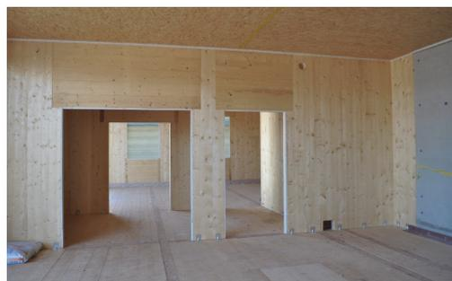
**Bild K.4 — Bauen in Brettspertholz – Fünfgeschossige Passivhäuser aus Brettspertholz-Elementen**
