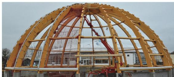
**Bild K.3 — Bauen in Brettschichtholz – Kuppel für ein Schwimmbad**
