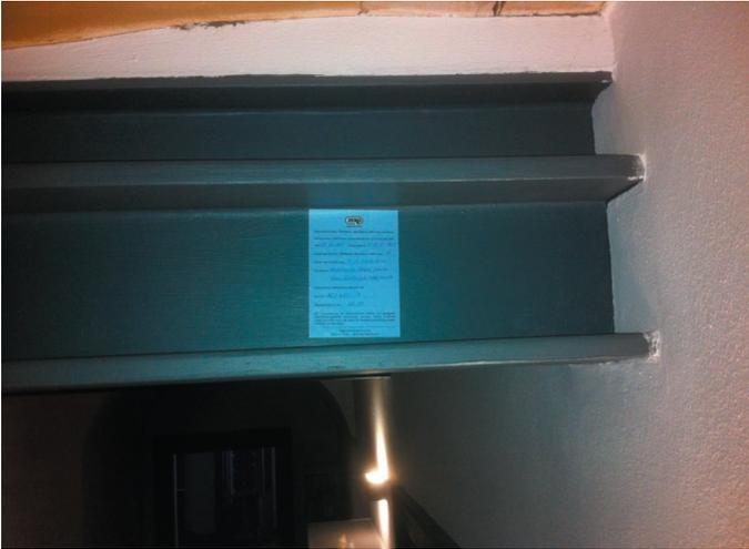
**Abbildung 3:** Reaktives Brandschutzsystem auf einem Stahlträger
