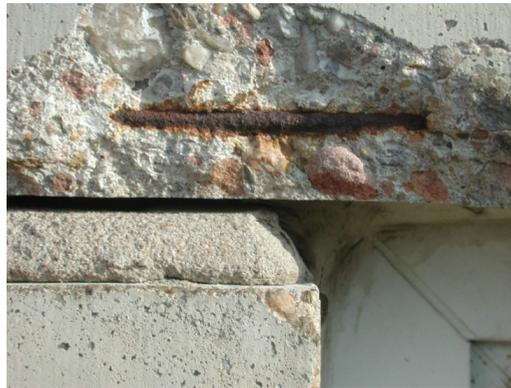
*Abb. 1.10 Typischer Carbonatisierungsschaden*
