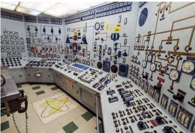
PHOTO 1.13 – La salle de commande du *NS Savannah*. Sur le panneau le plus à gauche au fond, on voit la représentation des 21 croix de contrôle (et non des 32 assemblages). On visualise autour du réacteur les deux branches primaires.
