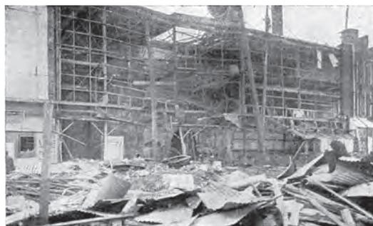
PHOTO 1.2 – Explosion d'une chaudière Climax dans les années 1920. Le réservoir central est percé d'une grande quantité de trous d'où une faible tenue des tuyauteries qui se greffent sur les trous, un défaut de conception aux conséquences redoutables lors de l'explosion qui a détruit le bâtiment contenant la chaudière (collection Marguet).
