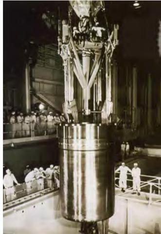
PHOTO 1.31 – L'enveloppe du réacteur de Shippingport (photo First Energy Corporation).
