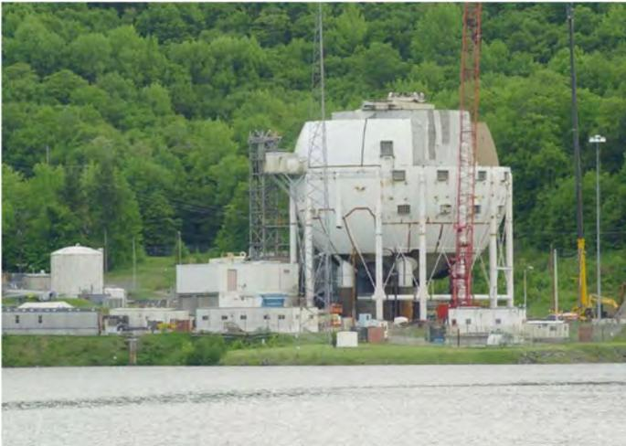
PHOTO 1.35 – Démantèlement de la sphère du réacteur de Yankee Rowe en date du 25 avril 2005.
