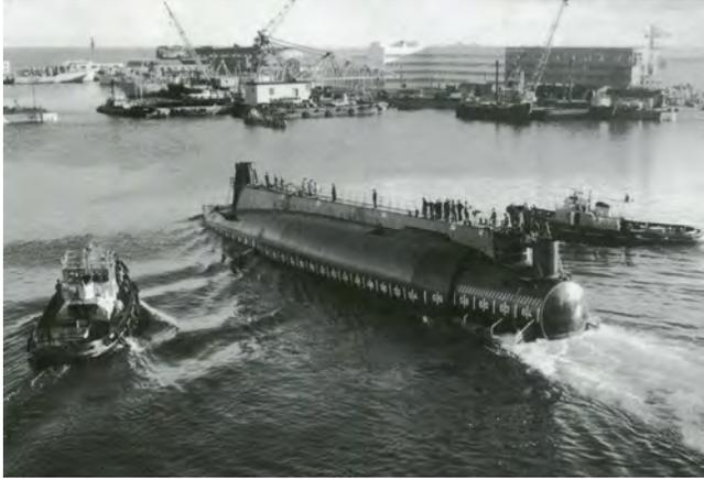
PHOTO 1.21 – Lancement du tronçon inachevé du Q244 pour libérer la cale de construction de l’arsenal de Cherbourg (photo DCN).
