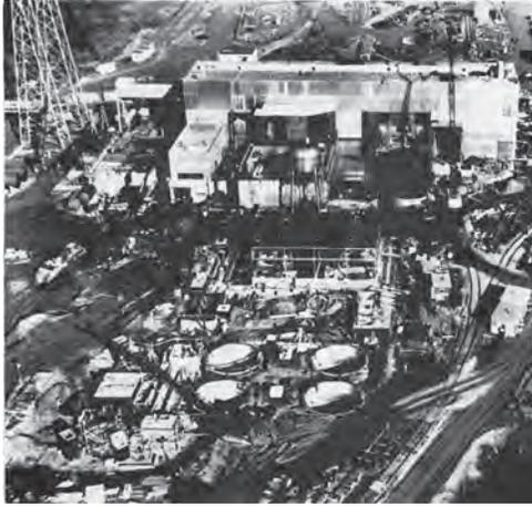
PHOTO 1.33 – Le centre de stockage des déchets de Shippingport en 1957. L'ensemble est construit sur une terrasse de sable et de graviers surélevée de 70 *pieds* au-dessus du niveau standard de la rivière adjacente, pour éviter tout risque de submersion. Des puisards placés à des intervalles de 50 *pieds* permettent de localiser spatialement toute fuite.
